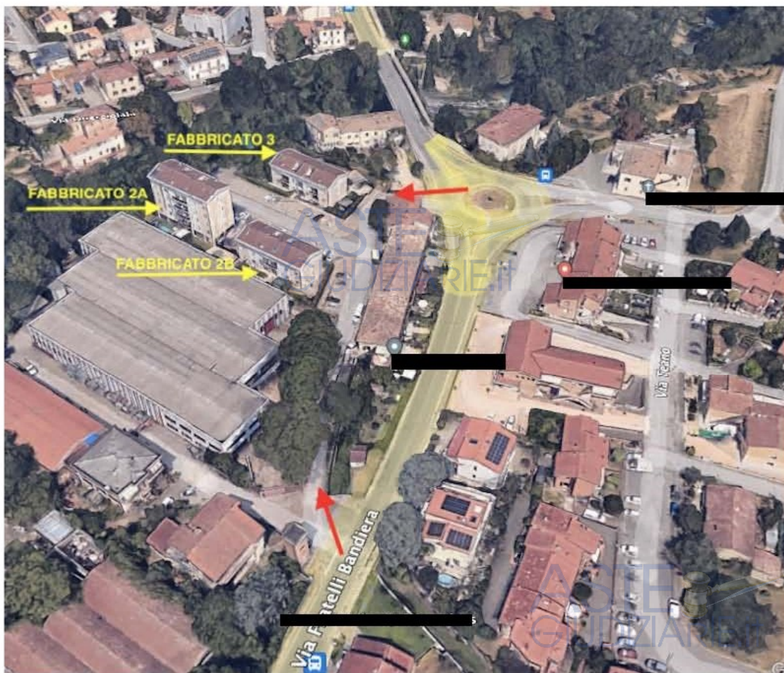
Foto n. 3 – Panoramica complesso residenziale
