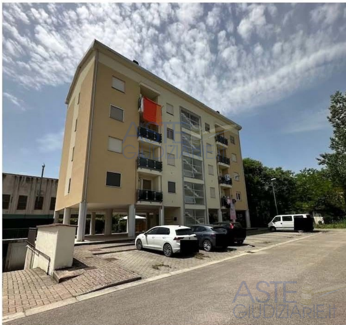
Foto n. 4 – Panoramica Fabbricato 2A
