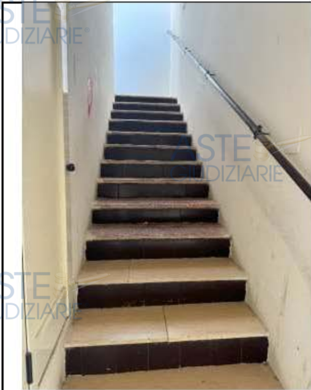
Foto 18 Scala di accesso al P1
