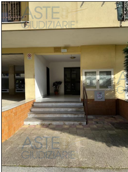
Foto 5 – Ingresso Fabbricato 2 Scala C
