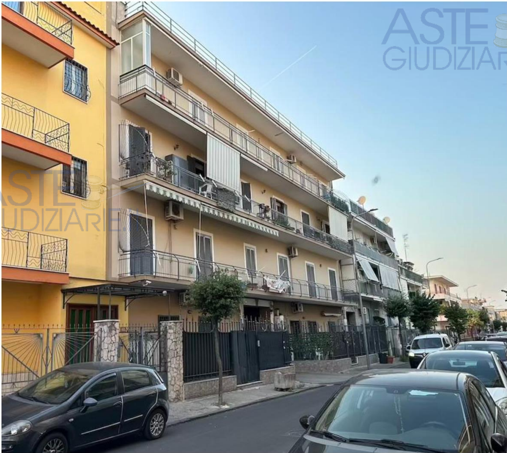
Foto n.1 – Panoramica fabbricato lato strada
