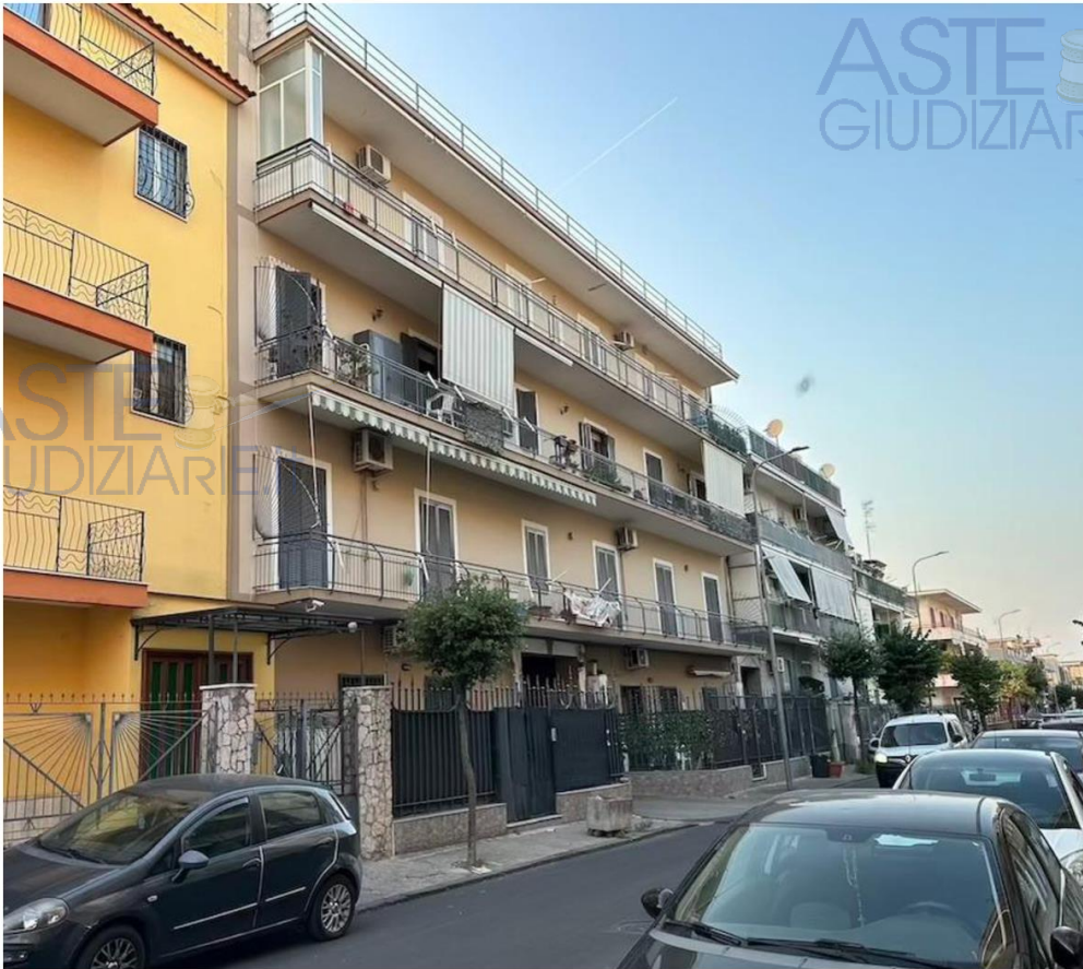
Foto n.1 – Panoramica fabbricato lato strada
