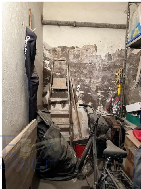
Foto n.2 – particolare locale cantinola
