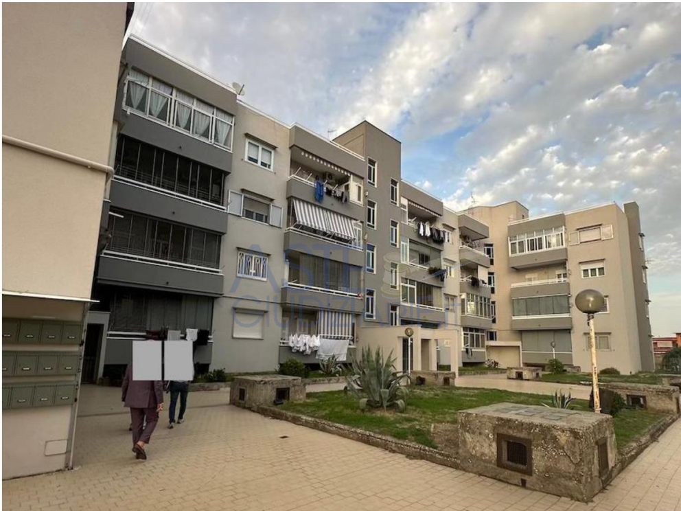
Foto n.1 – Panoramica fabbricato lato strada
