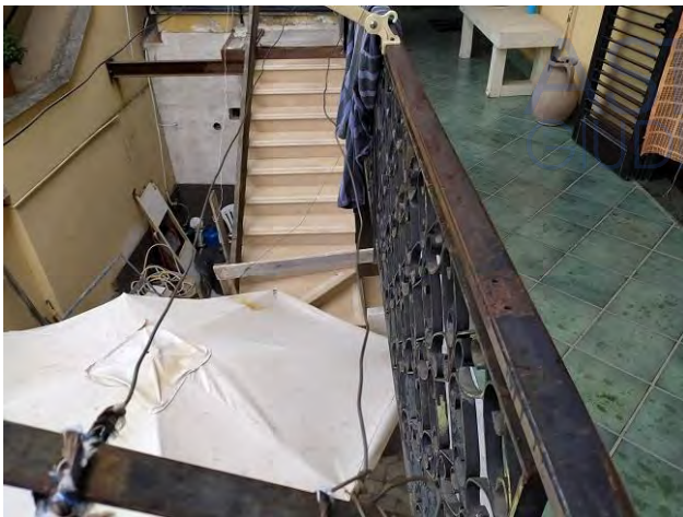
Scala esterna e ballatoio
