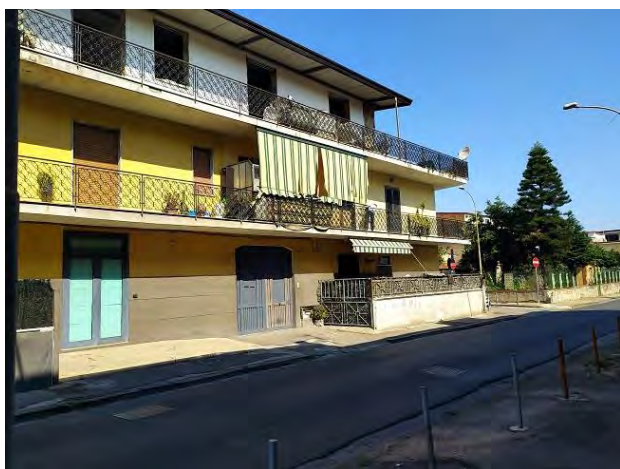
Il fabbricato di cui fa parte l'immobile pignorato
