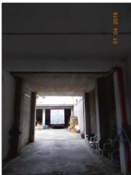
Ingresso al sub 2
