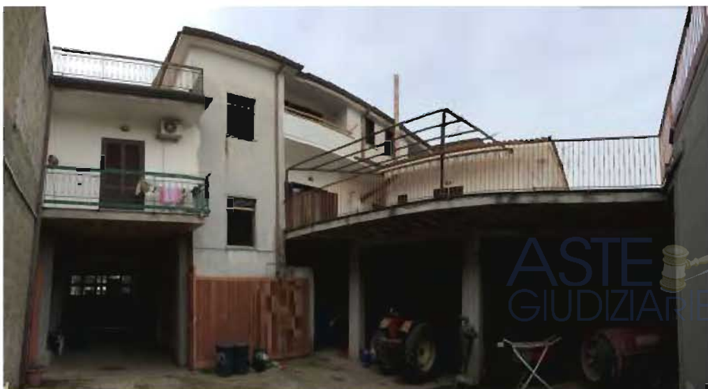
Vista del sub 2 dal sub 1
