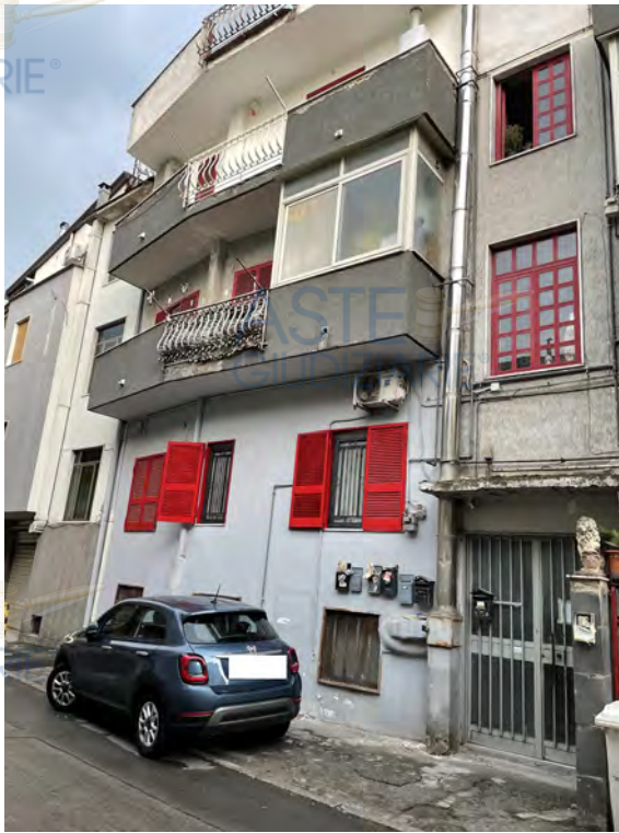
Fotografia n. 3 _ Prospetto su via Cosenza
