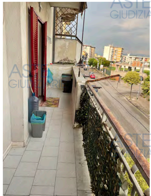
Fotografia n. 6 _ Balcone su via Diaz, vista nord/sud
