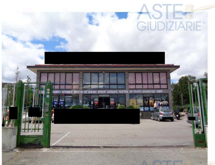
Veduta del Capannone da Via Roma
