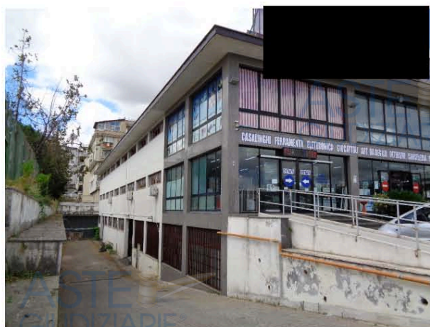
Prospetto lato est: rampa d'accesso al garage al PS1
