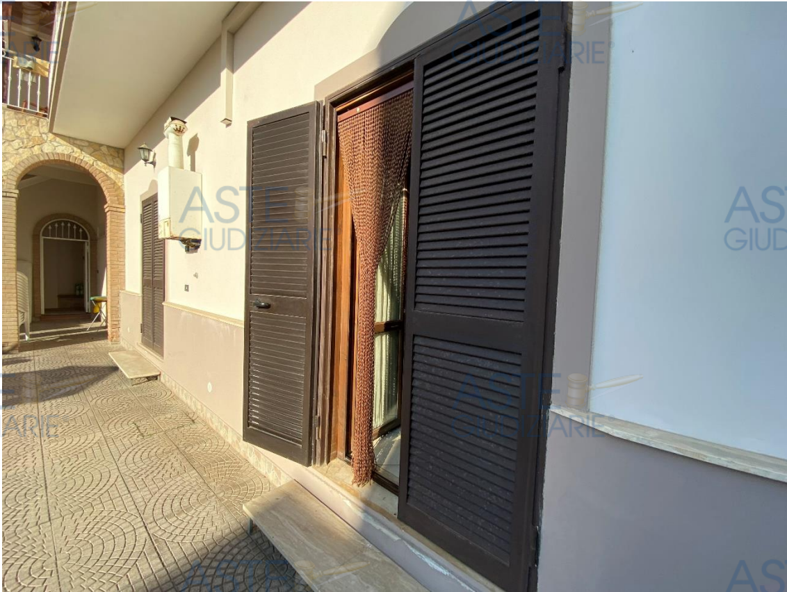
Ingresso sub. 2 lotto 1
