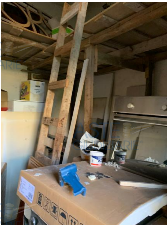
Foto n.6 – particolare vano deposito
