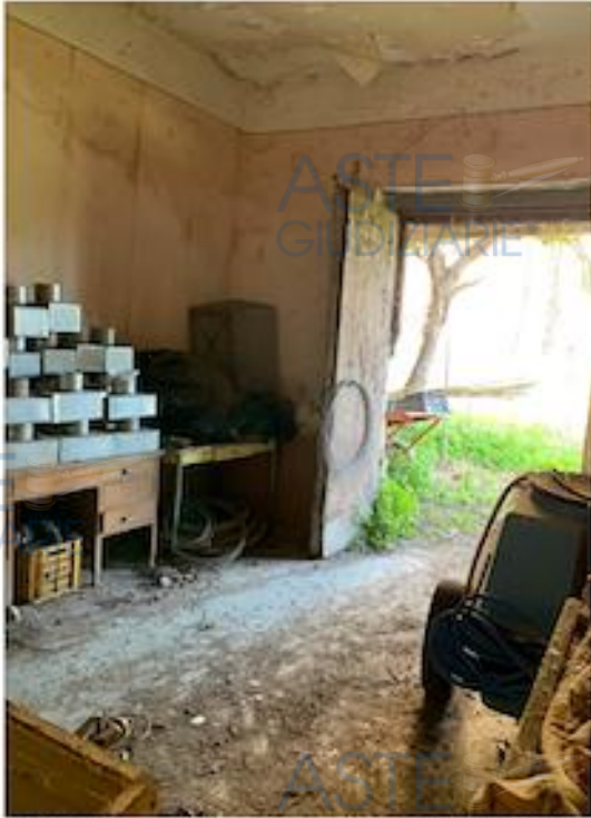
Foto n.4 – particolare ingresso in vano utile
