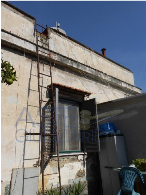
Foto n. 7 e n. 8 Il degrado dell'intonaco esterno e del coprifermo dell'aggetto
