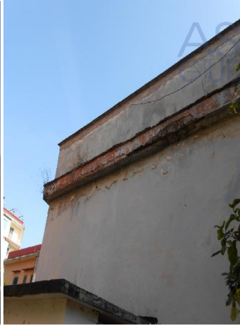
Foto n. 7 e n. 8 Il degrado dell'intonaco esterno e del coprifermo dell'aggetto
