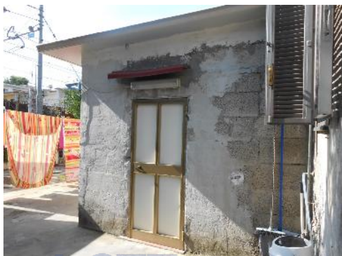
Foto n.13 : Abuso "B" L'ingresso
