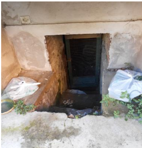
Foto n 27: Ingresso al vespaio
