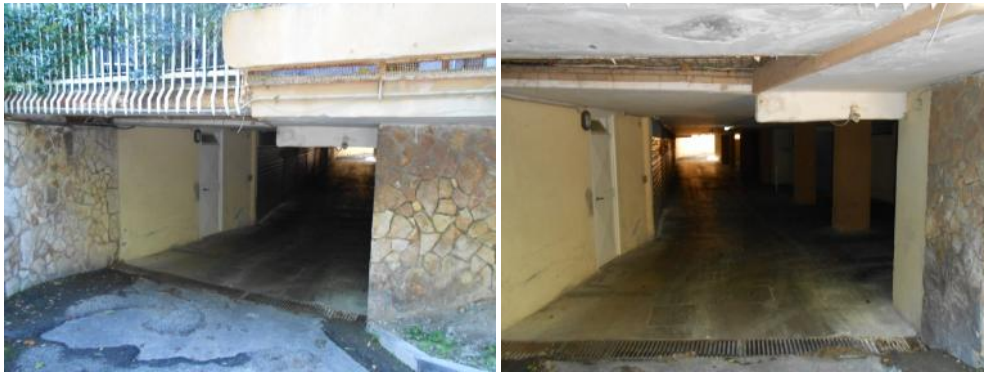
Foto n. 3 'accesso al piano seminterrato
