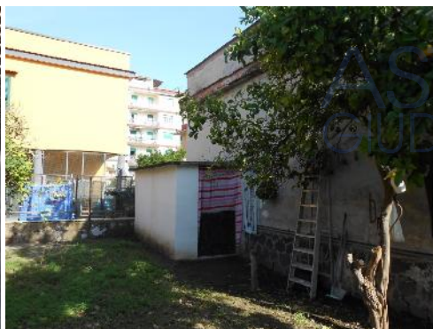
Foto n.14 Abuso "C" Il Deposito
