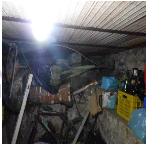
Foto n 27: Orditura del 1° solaio
