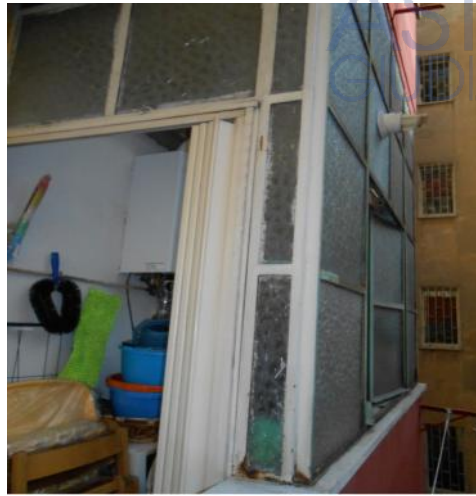
Foto n. 8 Ancora la veranda
