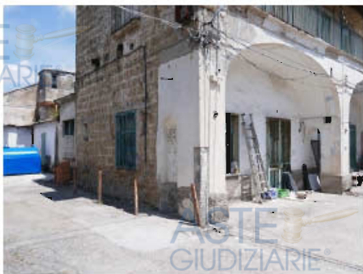
VISTA ESTERNA SUB 10 E 11
