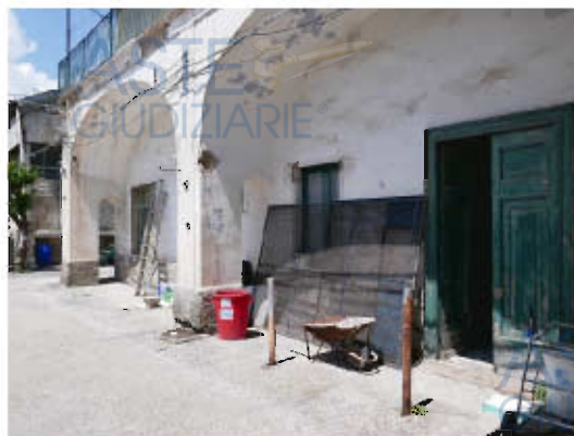
VISTA ESTERNA SUB 10 E 11
