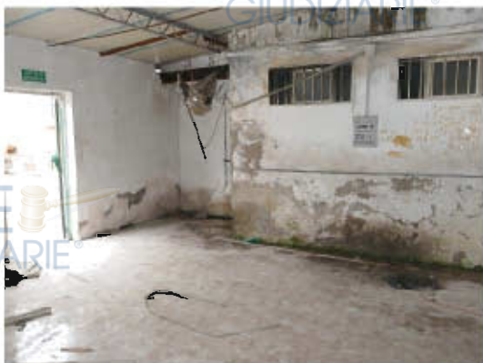
LOCALE DI ACCESSO AL CAPANNONE
