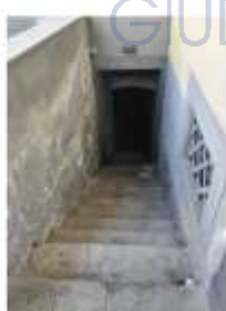
Foto n. 72 - Ingresso dal cortile comune Bene n. 1 - sub 52 e Bene n. 2 sub 57
