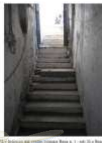
Foto n. 71 - Ingresso dal cortile comune Bene n. 1 - sub 52 e Bene n. 2 sub 57
