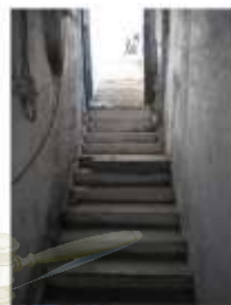
Foto n. 12 - Ingresso dal cortile comune Bene n. 1 - sub 52 e Bene n. 2 sub 57
