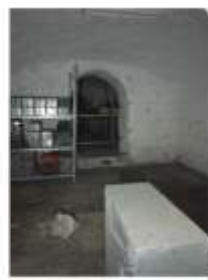
Foto n. 14 - Ingresso dal cortile comune Bene n. 1 - sub 52 e Bene n. 2 sub 57
