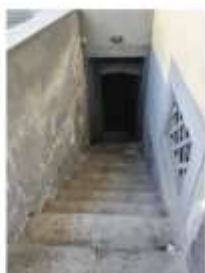
Foto n. 13 - Ingresso dal cortile comune Bene n. 1 - sub 52 e Bene n. 2 sub 57
