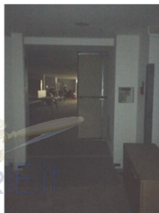
Foto n. 38 - Basse n. 2 - Porta di passaggio con immobile di proprietà aliena non oggetto di pignorato
