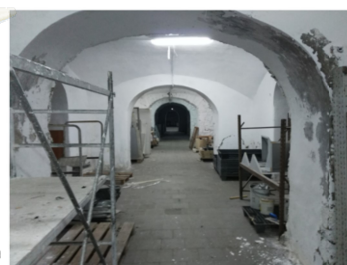
Foto n. 69 - Base n. 4 - traso di passaggio con il Base n. 1 del Lomo 3 sub 5f
