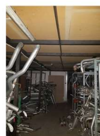
Foto n. 22 - Base n. 1 - Ambiente n. 11 e 12 - Soppalco
