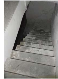
Foto n. 23 - Base n. 1 - Scala di collegamento con il sub 41
