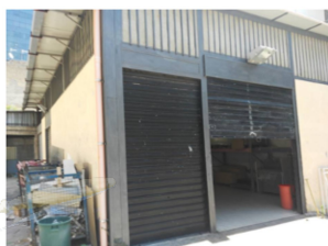
Foto n. 42 - Ingresso all'immobile - Bene n. 3 sub 7
