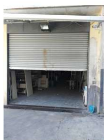
Foto n. 25 - Ingresso all'immobile - Bene n. 2
