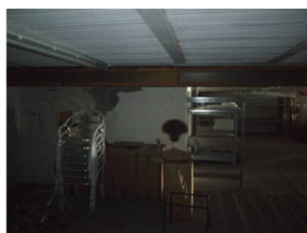
Foto n. 31 - Bene n. 2 - Soppalco
