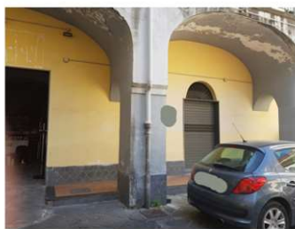
Foto n. 2 - Bene n. 1 - Ingresso
