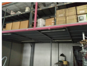
Foto n. 32 - Bene n. 2 - Soppalco
