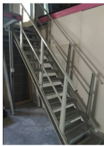
Foto n. 28 - Bene n. 2 - Rampa scala verso soppalco
