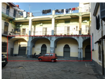
Foto n. 0 - Immobilità pignorata Bene n. 1 sub 59 - lato cortile interno
