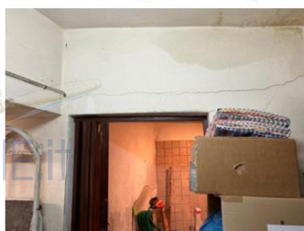
Foto n. 20 - Disimpegno - verso il bagno
