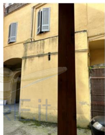
Foto n. 4 - Immobile pignorato - vista dal cortile comune
