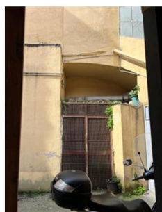
Foto n. 3 - Immobile pignorato - vista dal cortile comune
