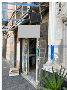
Foto n. 2 - Immobile pignorato - accesso dal corso Secondigliano
