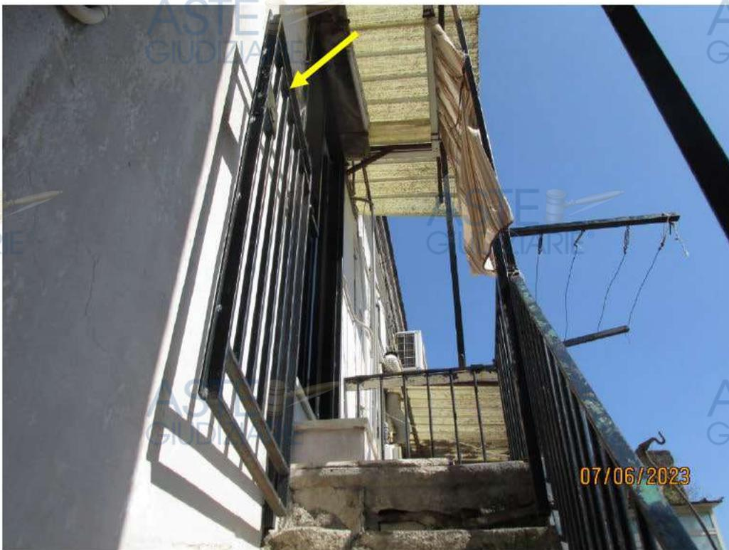
**Fotografia 16 – La scala, si regge su una maglia di archi contrapposti, dove i pianerottoli di arrivo rappresentano la parte terminale del solaio di calpestio dei vari piani, essa termina al secondo piano per servire il solo appartamento pignorato, dove risulta installato un cancelletto in ferro di protezione.**
