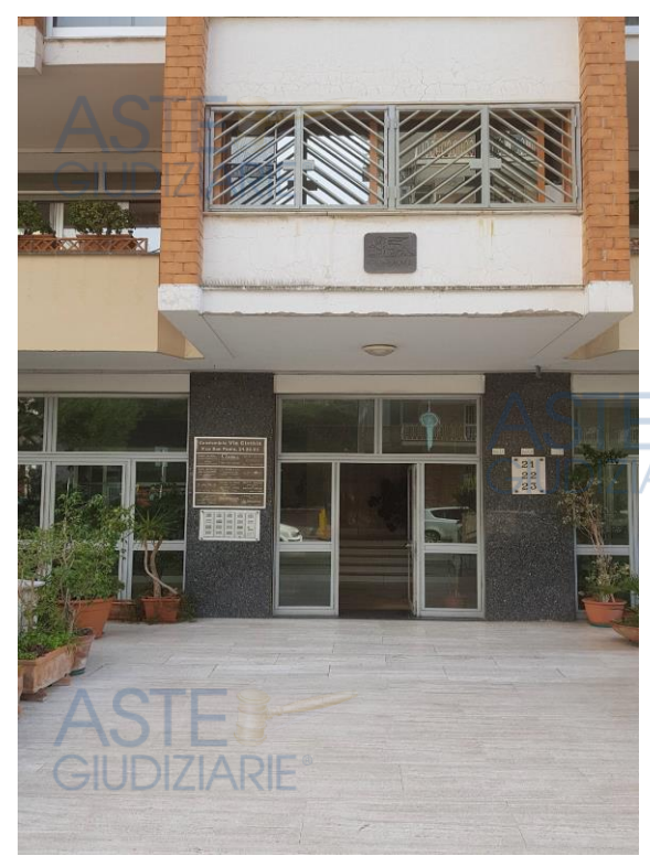
Vista cancello di accesso
