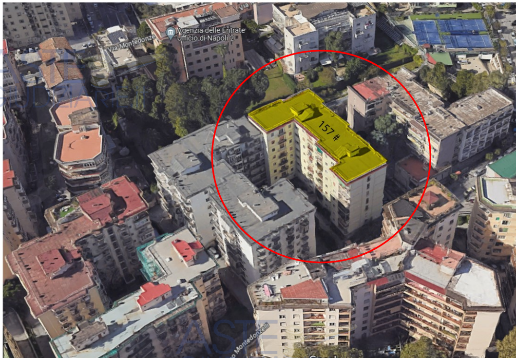
(Vista del più ampio fabbricato di cui il cespite in esame ne è parte integrante )
