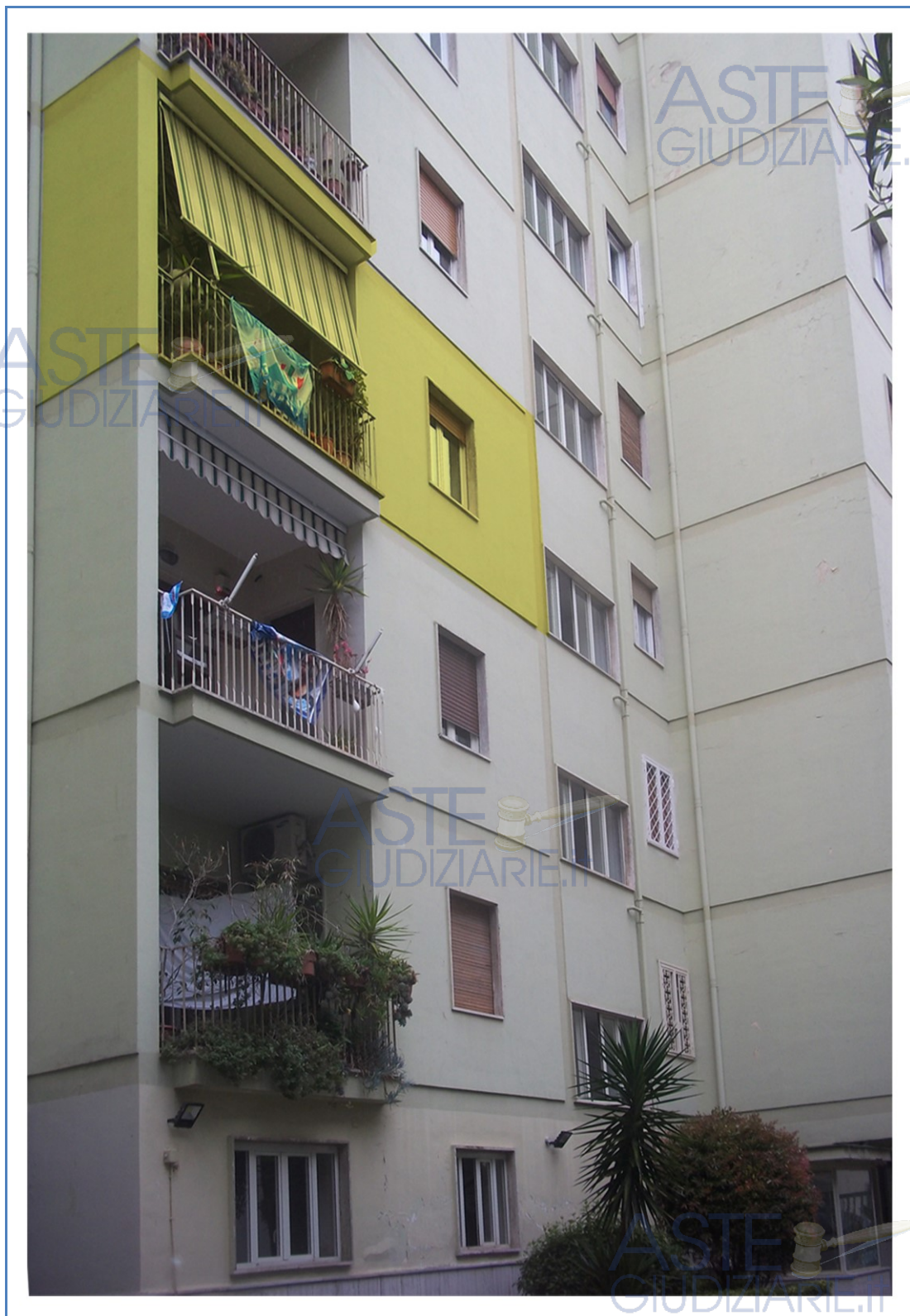
(Prospetto frontale – Individuazione del cespite nel più ampio Fabbricato - LATO BALCONE A )
