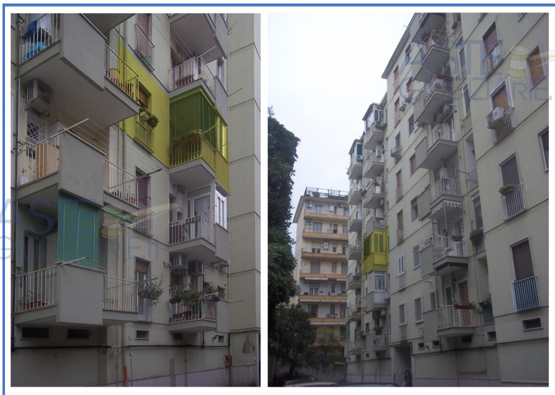
(Prospetto retrostante – Individuazione del cespite nel più ampio Fabbricato - LATO BALCONE B)
