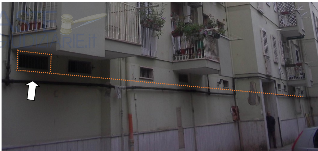
(Particolare delle aperture presenti sul retrostante prospetto .)
