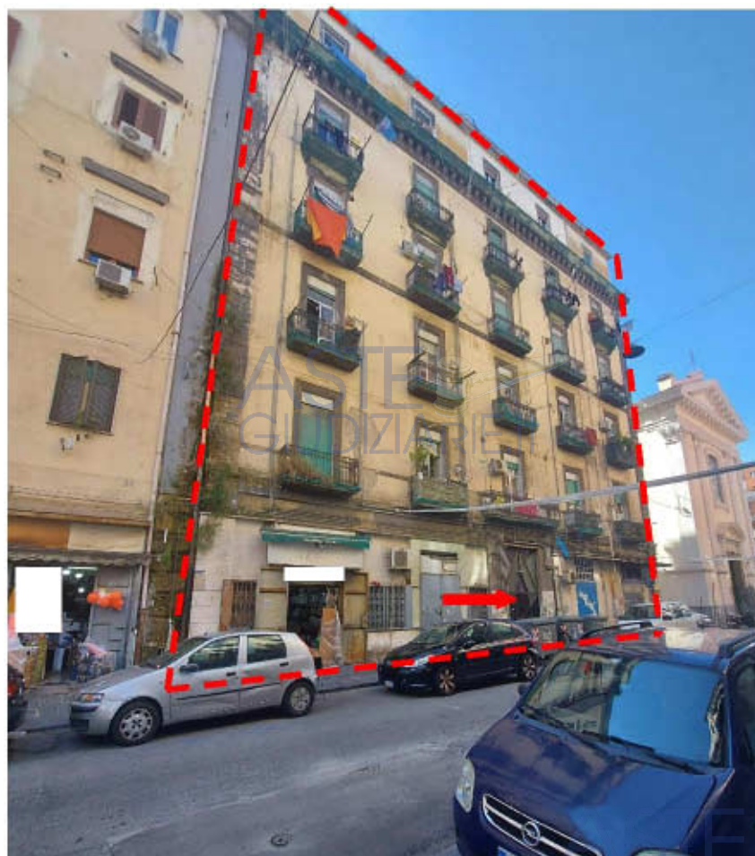
prospetto principale fabbricato via Milano - indicazione accesso fabbricato al civico 40
