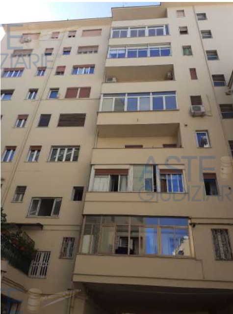
Foto 02 Facciata lato corte interna
