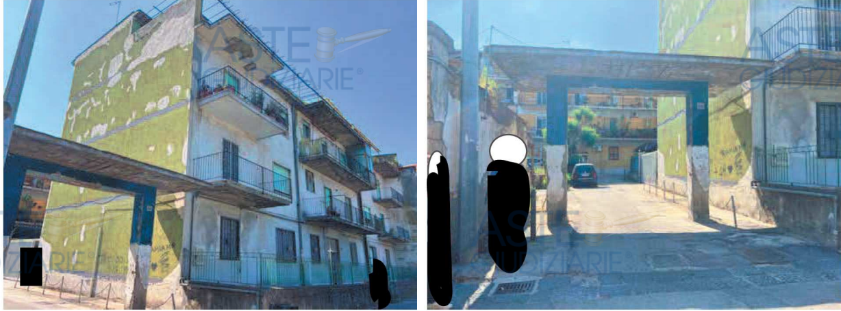
Vista prospettica del fabbricato "principale" con accesso dal civico n. 50A di via Luigi Martucci e dettaglio del varco carrabile che immette nell'area cortilizia che circonda i manufatti del complesso cui afferisce il fabbricato
