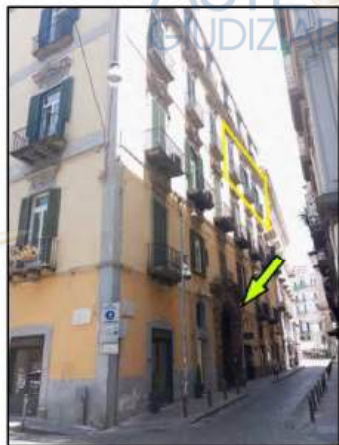
Fig. 2 Il fabbricato di via Carlo Poerio n. 110
