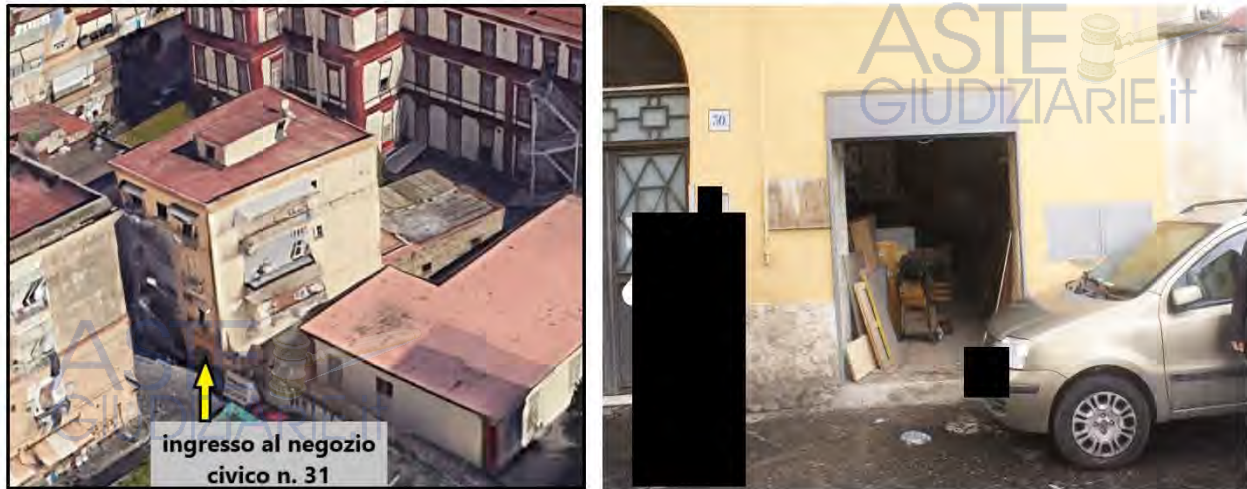
Fig. 2a, 2b Il fabbricato di via Santa Maria delle Grazie n.30 con l'individuazione dell'ingresso al negozio civico 31
