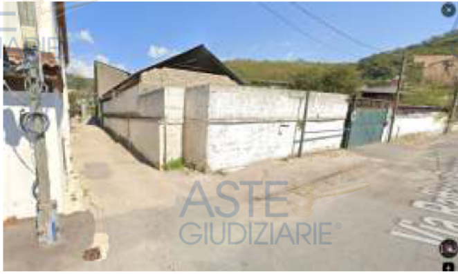
Accesso al complesso dalla vi Ruggiero
