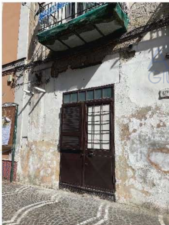
Particolare dell'ingresso dal civico 47 bis del Corso IV Novembre.
