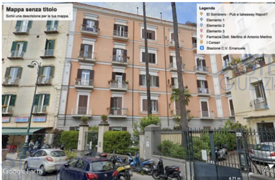
Vista del Fabbricato
