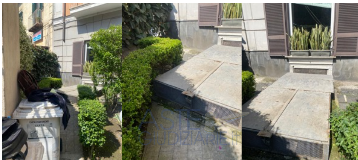
Vista della struttura in ferro e della botola che consente l'ingresso al locale deposito
