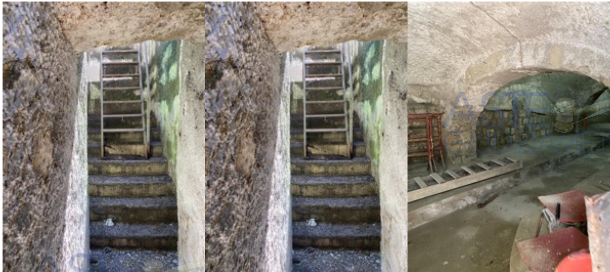
Scala d'accesso al locale deposito e interno locale
