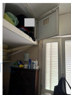
Foto n. 59 - Bagno n.2 - zona lavanderia
