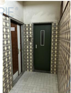
Foto n. 7 - Vano scala del fabbricato
