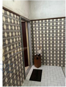
Foto n. 8 - Vano scala del fabbricato - accesso all'immobile pignorato
