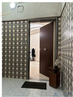
Foto n. 9 - Vano scala del fabbricato - accesso all'immobile pignorato
