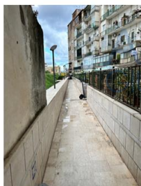
Foto n. 4 - Corridoio esteno di accesso alla scala E
