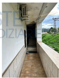
Foto n. 6 - Corridoio esteno di accesso alla scala E
