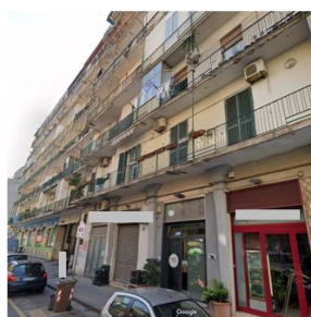
Foto n. 2 - Fabbriato in cui è ubicato il espite pignozato
