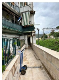
Foto n. 5 - Corridoio esteno di accesso alla scala E
