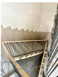
Foto n. 7 - Vano scala E
