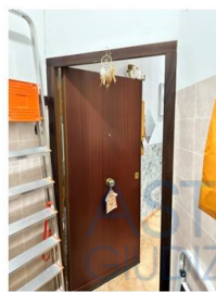
Foto n. 10 - Accesso all'immobile pignozato dal ballatoio comune
