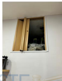
Foto n. 17 - Soppalco sul bagno accessibile dalla cucina
