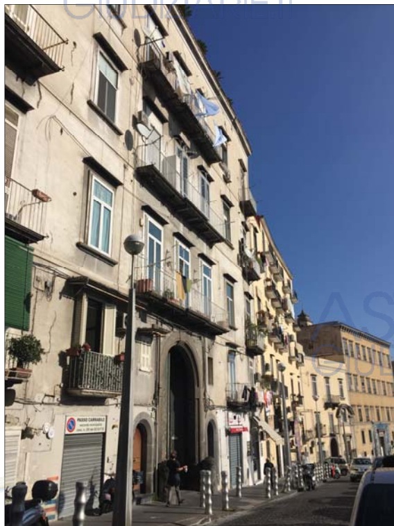
Figura n.5: Prospetto fabbricato su Via Salvator Rosa civ. n. 181
