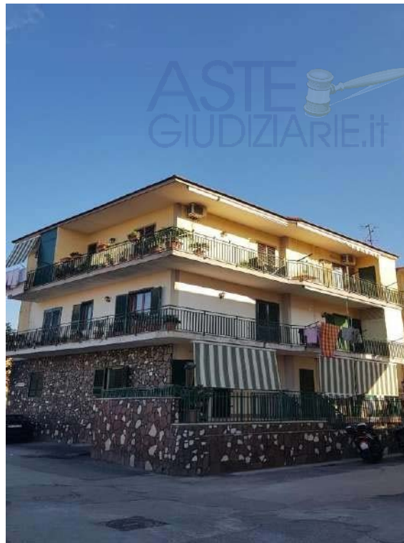
Vista accesso all'immobile
