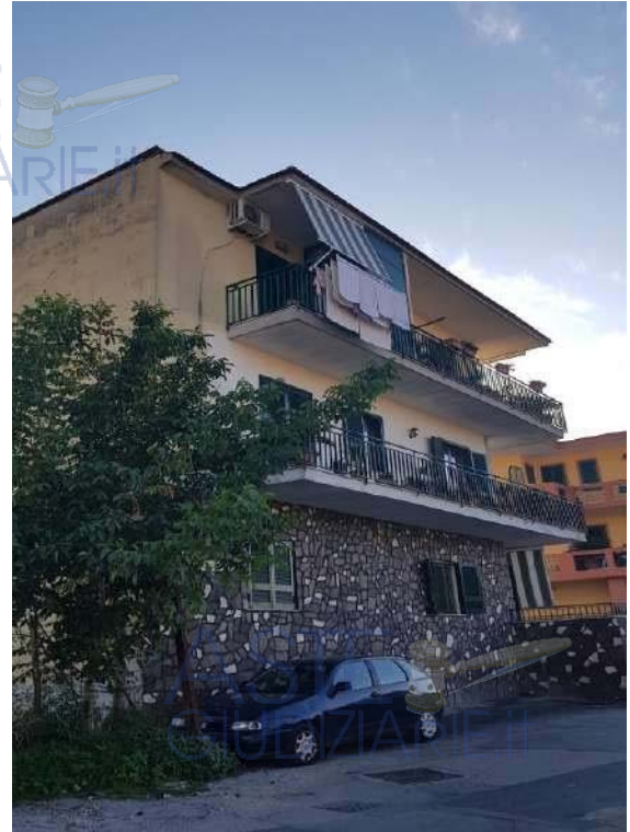
Vista di insieme stabile in cui è allocato il cespite pignorato al piano terra
