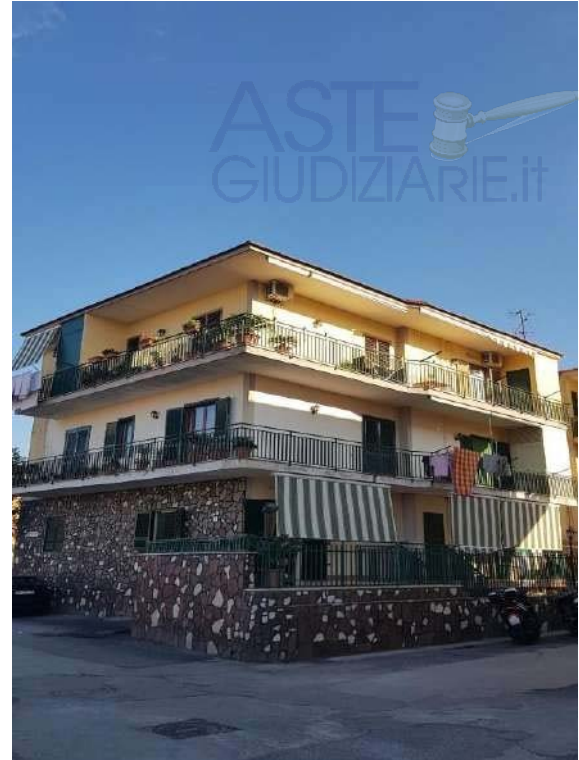
Vista accesso all'immobile
