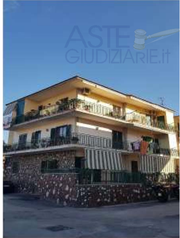
Vista accesso all'immobile
