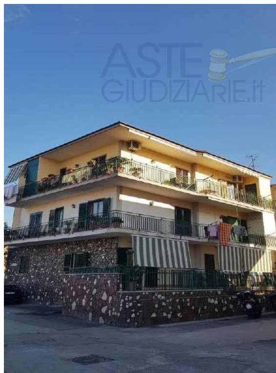
Vista accesso all'immobile
