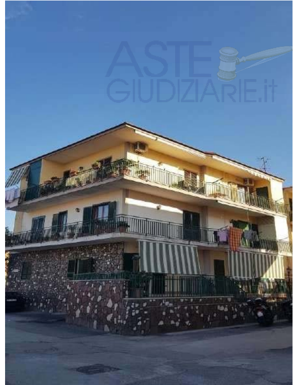
Vista accesso all'immobile
