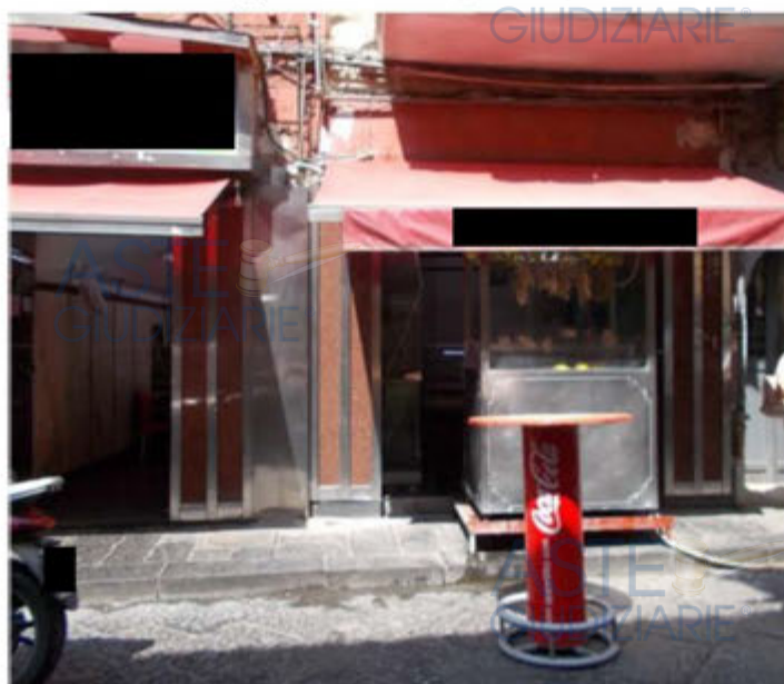
vista esterna civico n. 102 (locale a destra)
