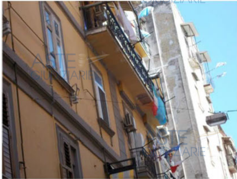
Balconata vista dal piano strada
