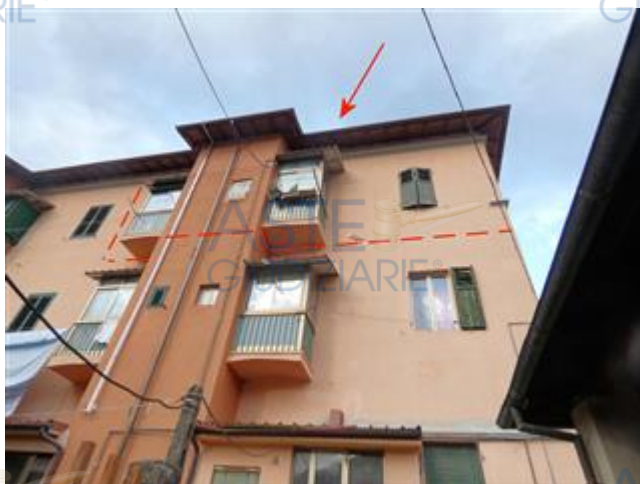
Vista dal retro - Lato Ovest
