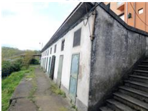
Area di accesso ai ripostigli esterni
