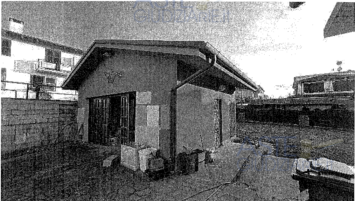
Sotto Foto rimessa Sub. 6
