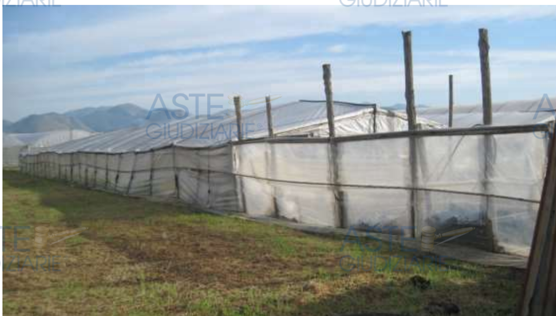
F. 42, particella 501 – vista da Sud - Est
