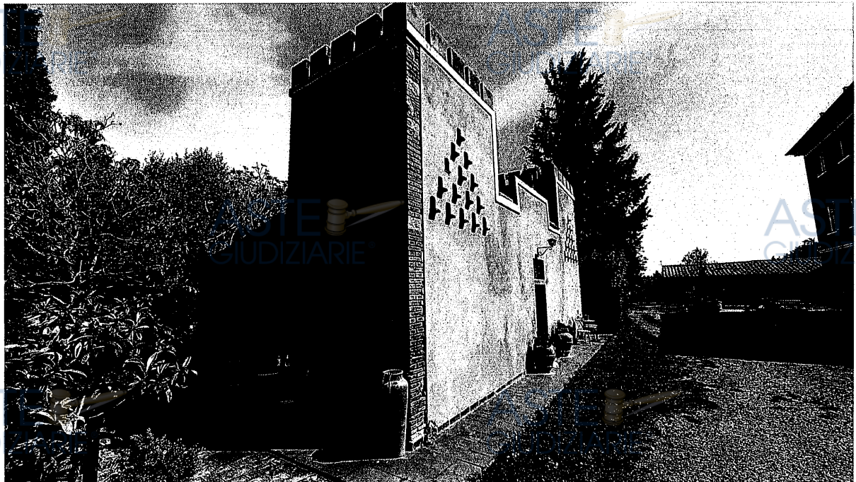
Vista dal giardino interno
