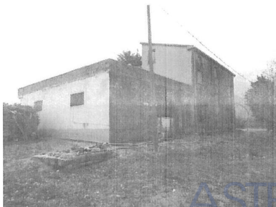
Foto 3 – Esterno fabbricato - retro
