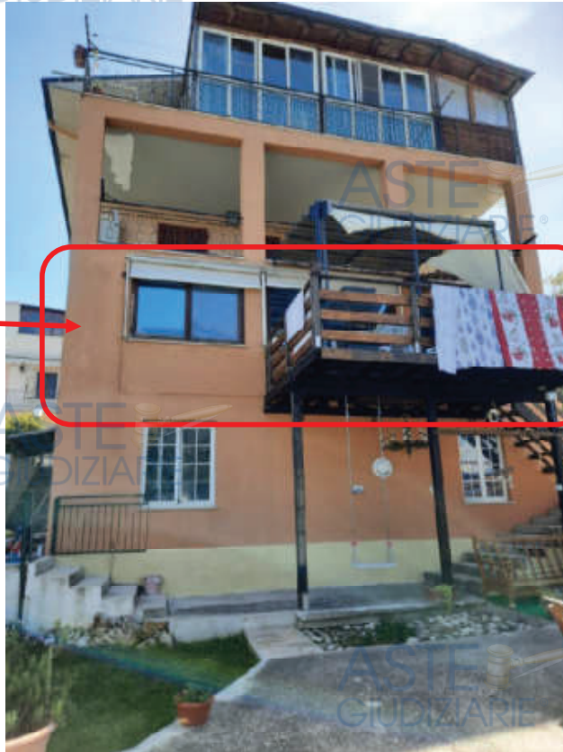
Foto n.12 (SUB 7) Veduta d'insieme e indicazione dell'u.i. sub 7---foto scattata dal livello interrato della corte comune
