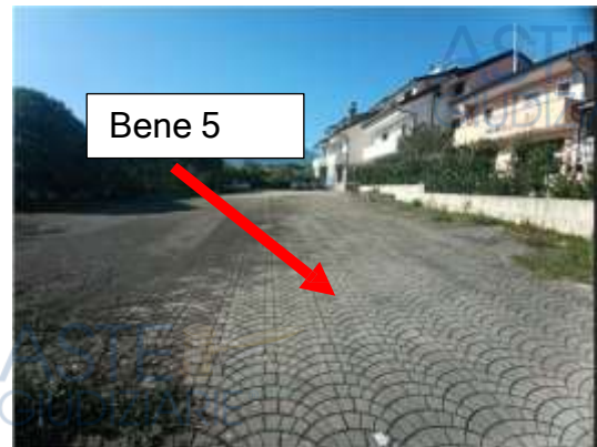
Vista del piazzale di ingresso
