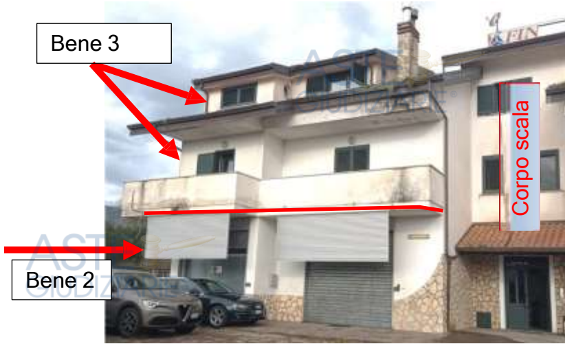
Vista lato ingresso
