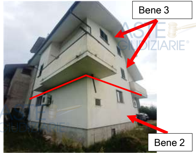
Vista dal retro
