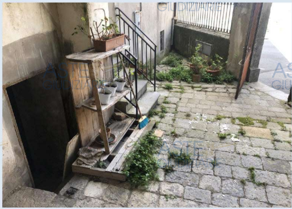
Fig. 21 - Ingresso da area comune
