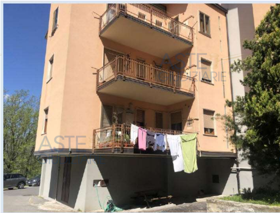
Fig. 16 – Fabb.to in via XXV Aprile Prospetto laterale-posteriore
