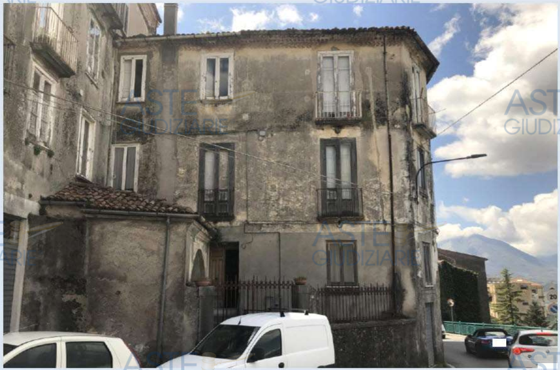
Fig. 18 – Fabb.to via Roma ingresso est
