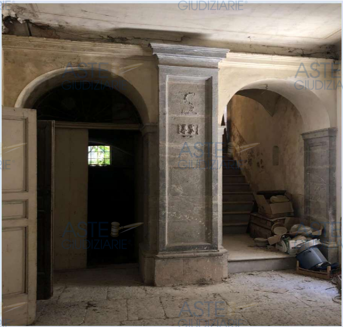
Fig. 17 – Fabb.to via Roma; Ingresso piano T con indicazione della data presunta di realizzazione del fabbricato
