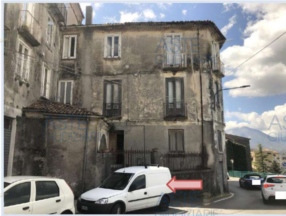
Fig. 22 - Ingresso da via Roma
