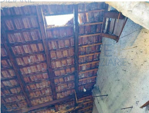
Figura 38: particolare tetto deposito
