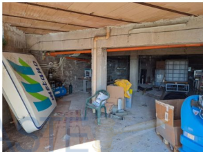
Fig.13 Foto bene 2 deposito Piano Seminterrato
