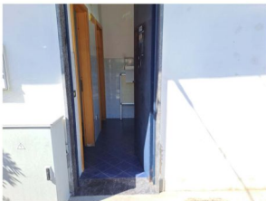
Fig.12 Foto bene 2 Locali w.c. Piano Terra
