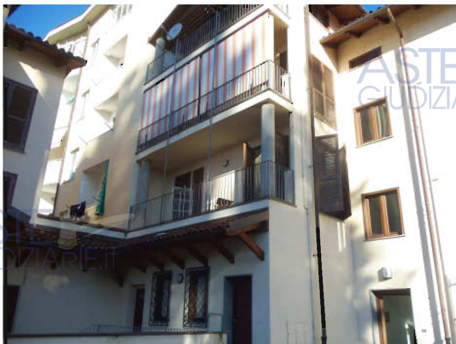
Vista esterna dell'immobile (alloggio) ubicato al piano primo di via Pasquale Educ n° 30, censito al Catasto fabbricati al Foglio 5 part. 1217 sub 8.
