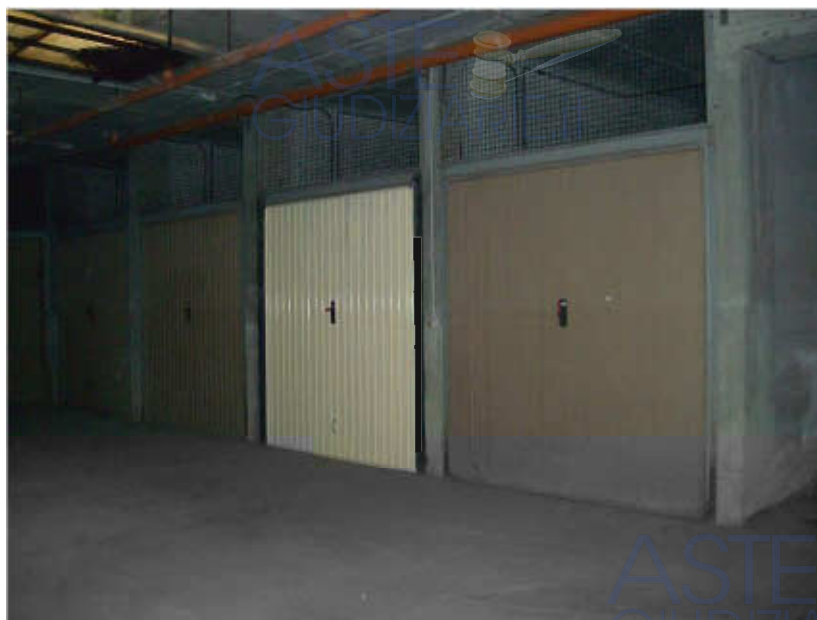
Vista esterna di alcuni degli immobili (box auto) ubicati al piano seminterrato del complesso condominiale ubicato in Piazza Martiri della libertà n° 9, censiti al Catasto fabbricati al Foglio 5 part. 417.
