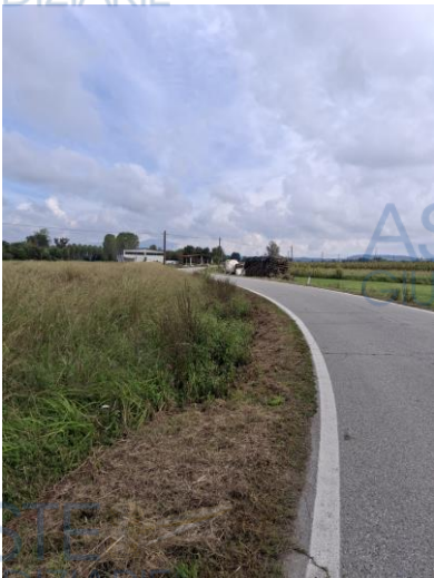
Strada di accesso asfaltata
