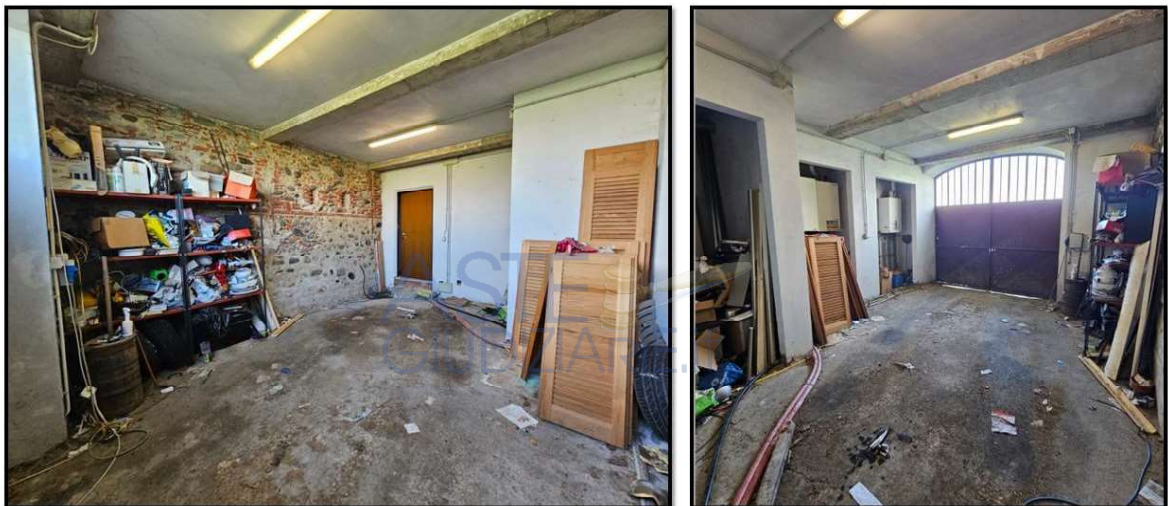
Foto 24-25 locale deposito piano terra
