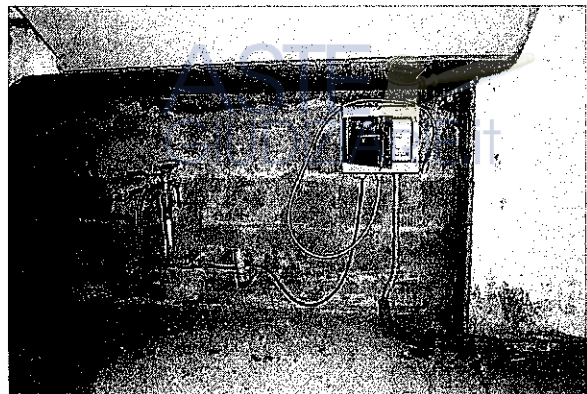
Vecchio allacciamento autoclave oggi rimosso
