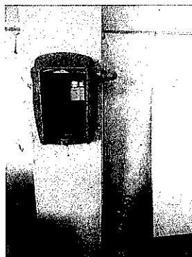
Lancia antincendio interna
