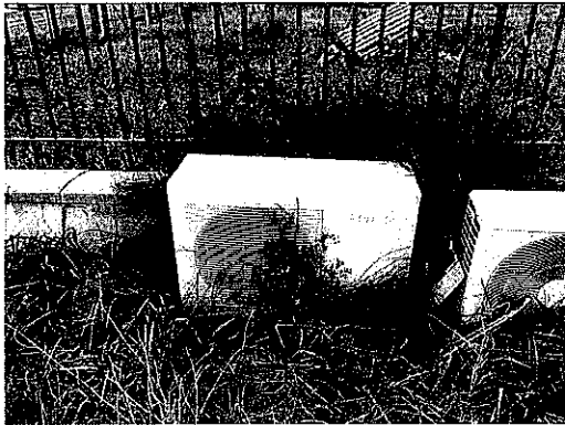
Unità esterna moto condensante
