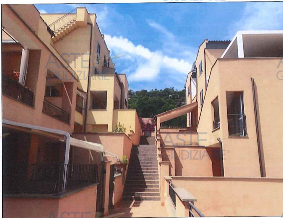
Vista del complesso Comparto CR020 lotto 3
