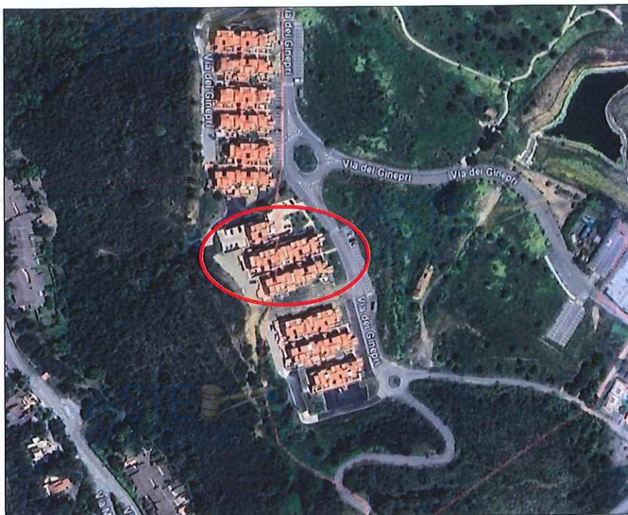
Vista Aerea del complesso loc. Santa Maria
