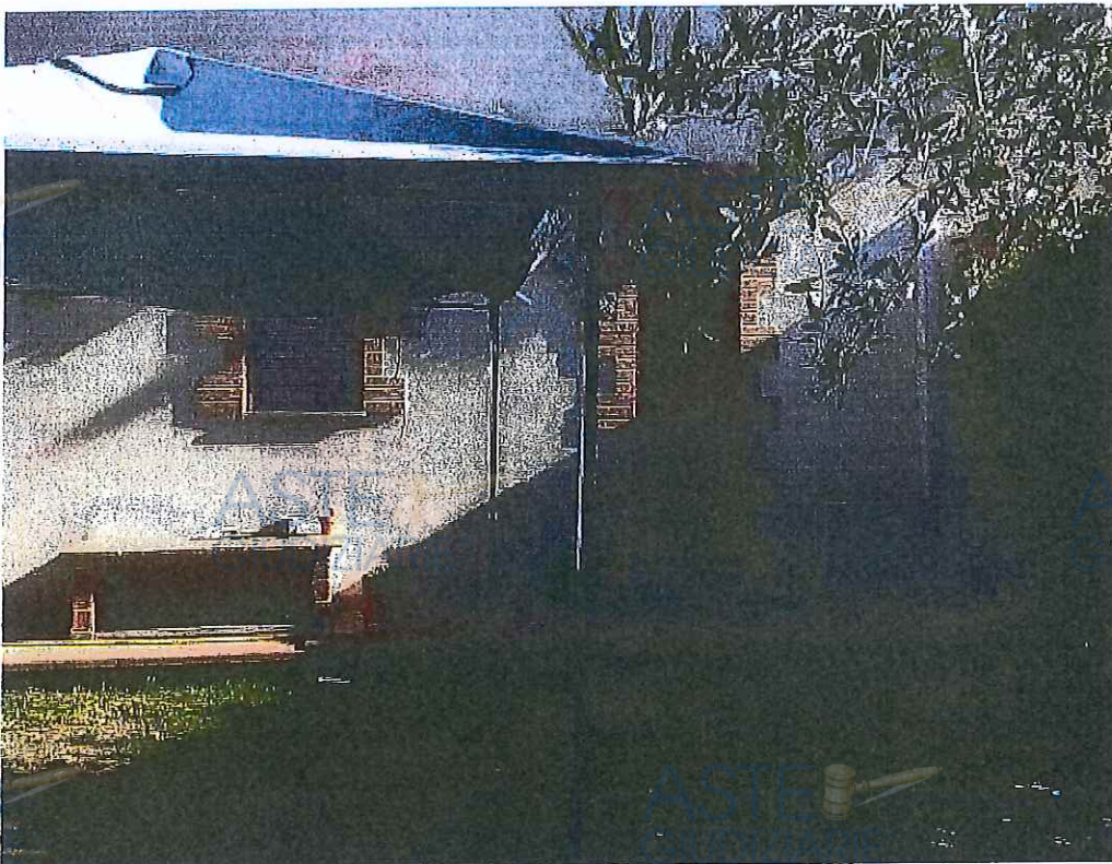
Fotografia 20: Corte esclusiva sub 5 dell'appartamento sub 9 verso la portafinestra del soggiorno
