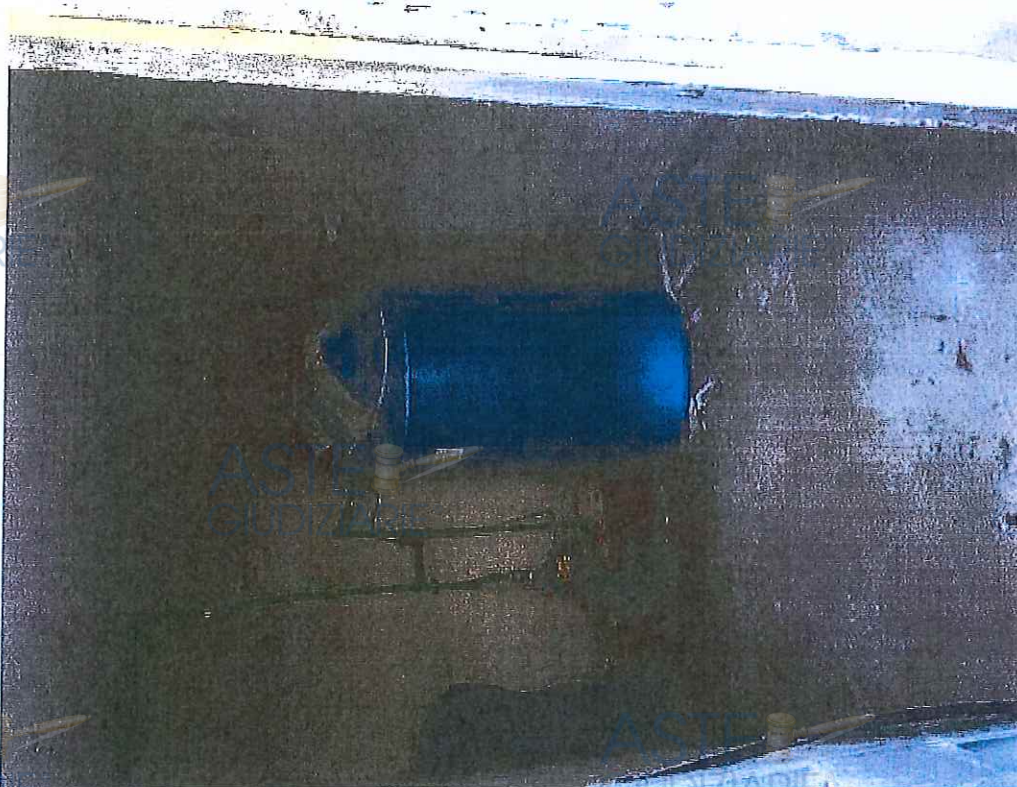
Fotografia 6: Vista del locale autoclave sub 7 lato ingresso
