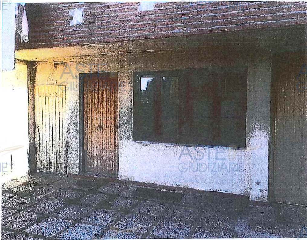
Fotografia 3: Vista porta e finestra della taverna in sostituzione della basculante del garage sub 14
