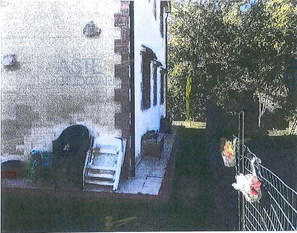
Fotografia 17: Corte posteriore tra il sub 8 e il sub 9 senza divisione
